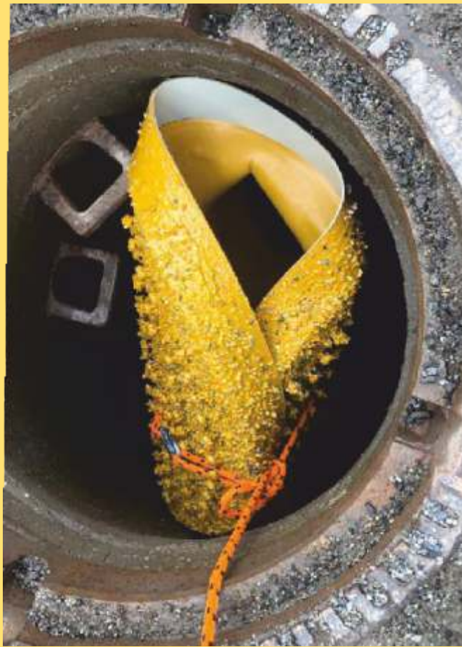
RIVESTIMENTO COMPLETO DEL POZZETTO
