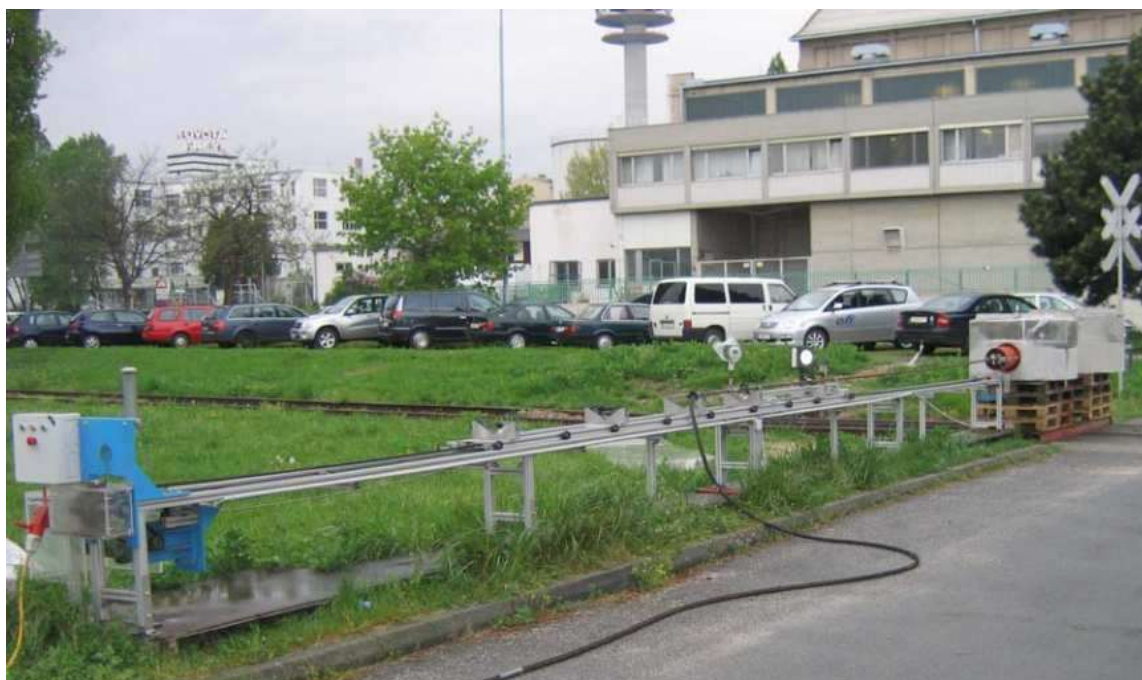
Immagine 4: disposizione del test ad alta pressione
