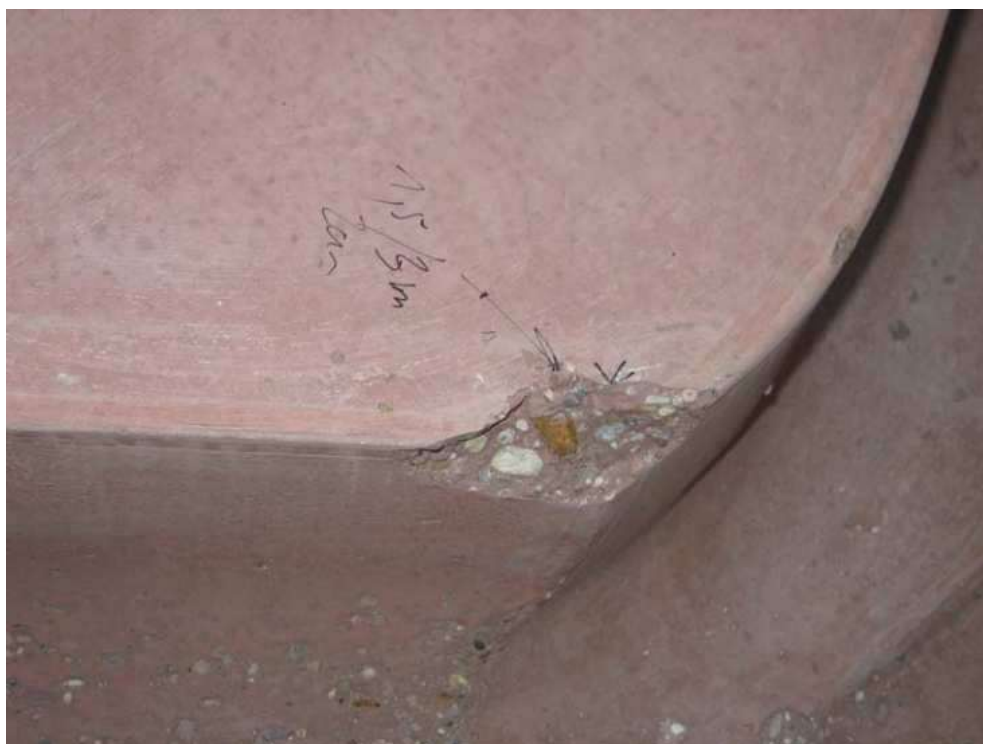
Immagine 25: pozzetto in cls SCC ad alta prestazione – 1,5 kg aus 3,0 m
