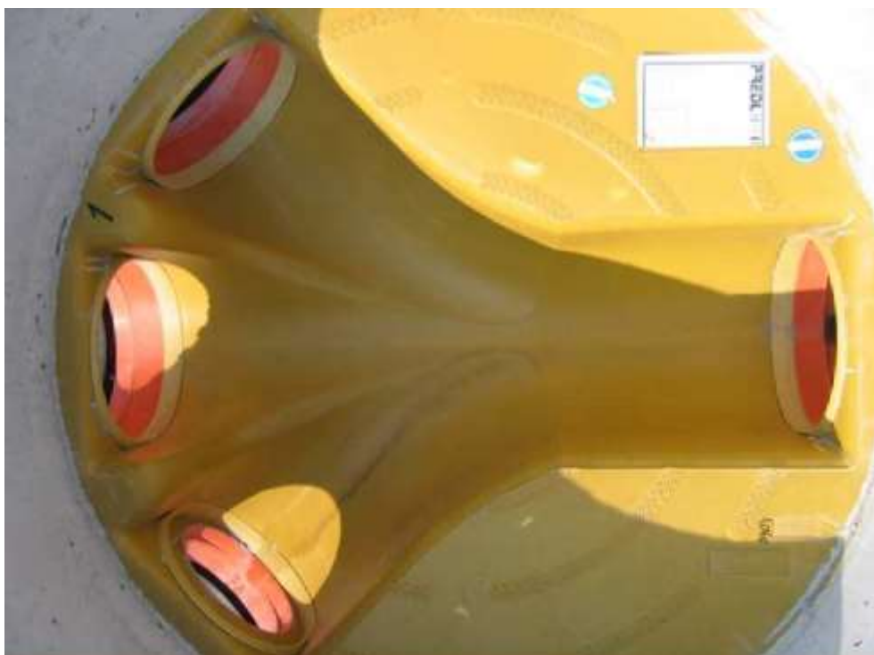
Immagine 2: pozzetto con rivestimento in PP termoformato
