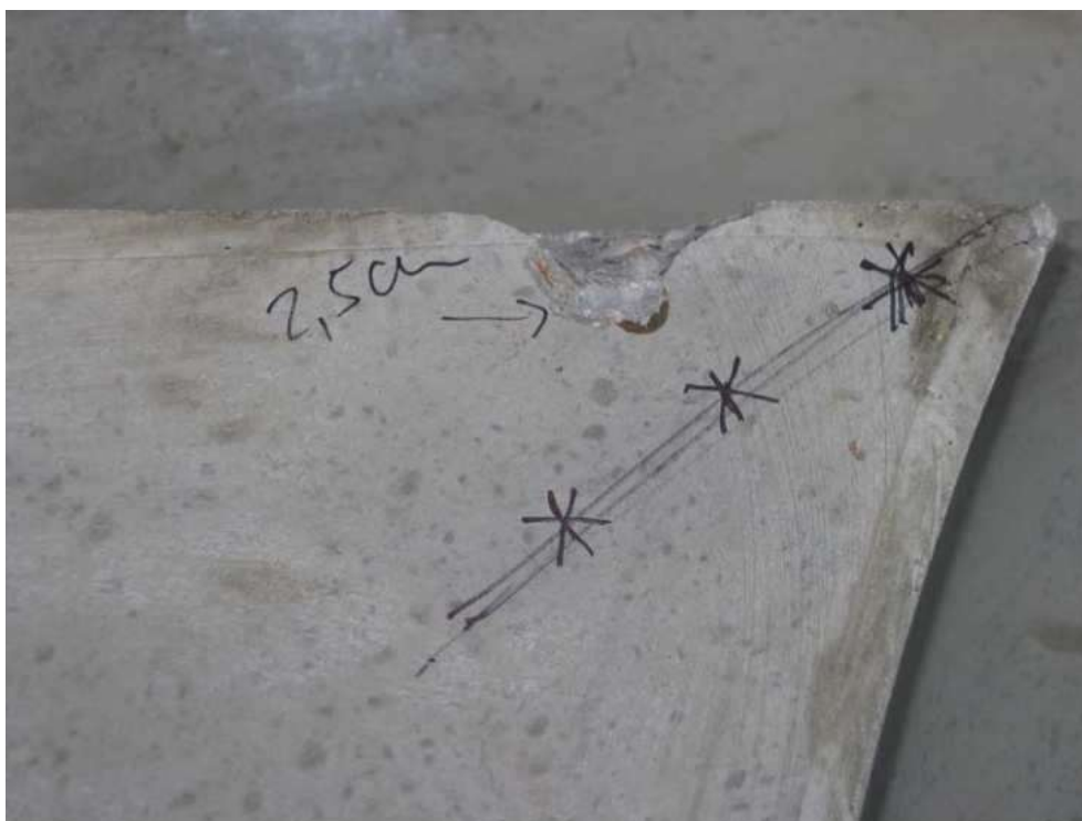
Immagine 19: pozzetto in calcestruzzo SCC- 1,5 kg da 3,0 m
