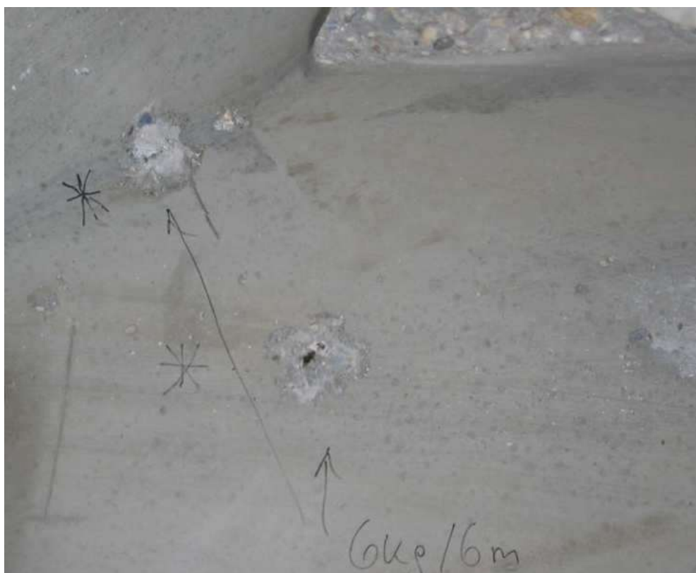
Immagine 22: pozzetto in calcestruzzo SCC – 6 kg da 6,0 m
