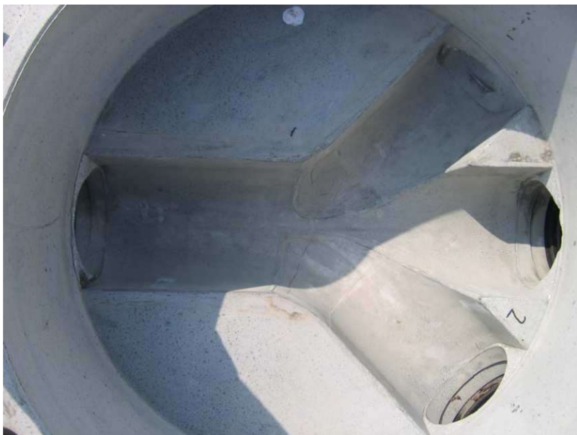
Immagine 2: campione di prova 2 / base pozzetto in SCC / senza manicotti a tenuta
