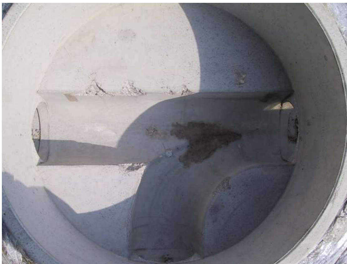
Immagine 8: campione di prova 8 / base pozzetto in SCC (dopo prova resistenza agli urti)
