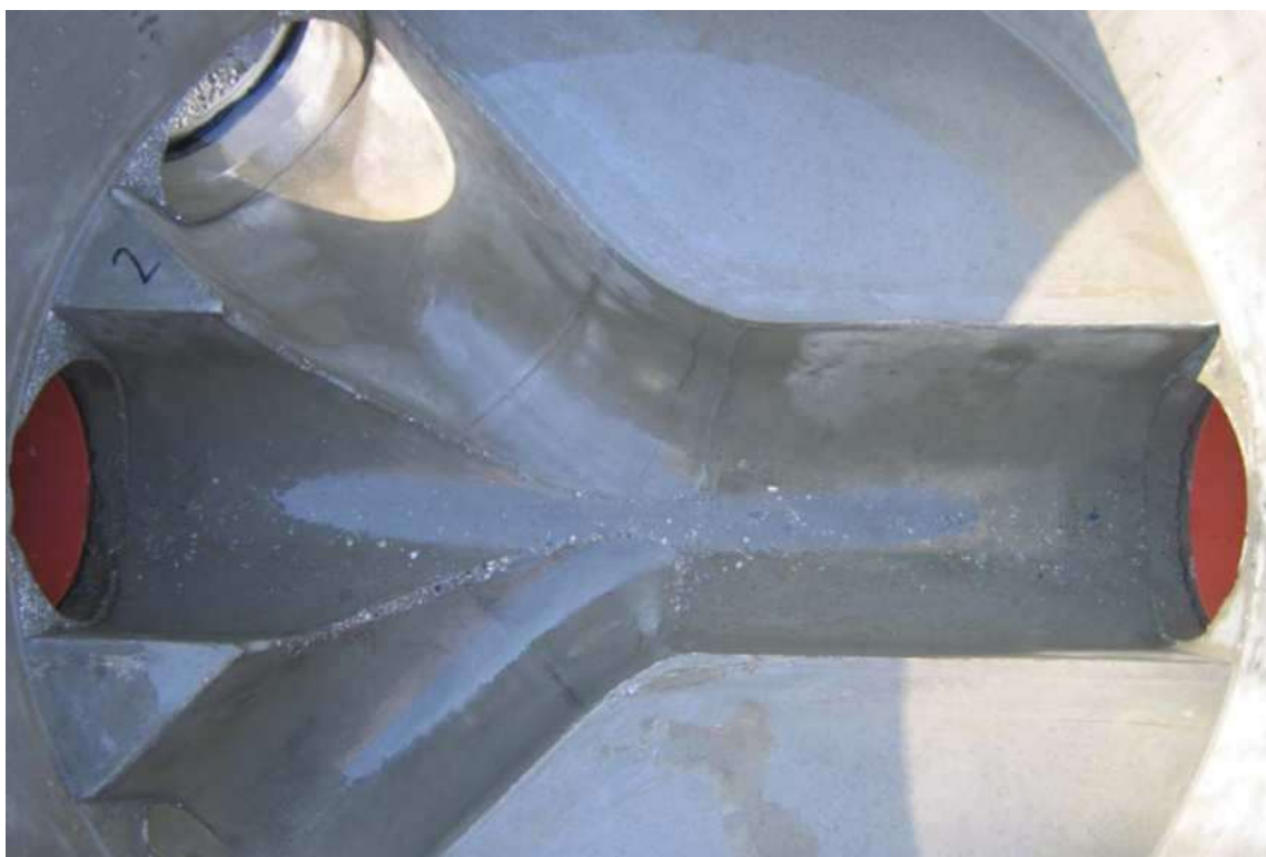
Immagine 39: pozzetto in CLS SCC DN 250 dopo 50 passaggi
