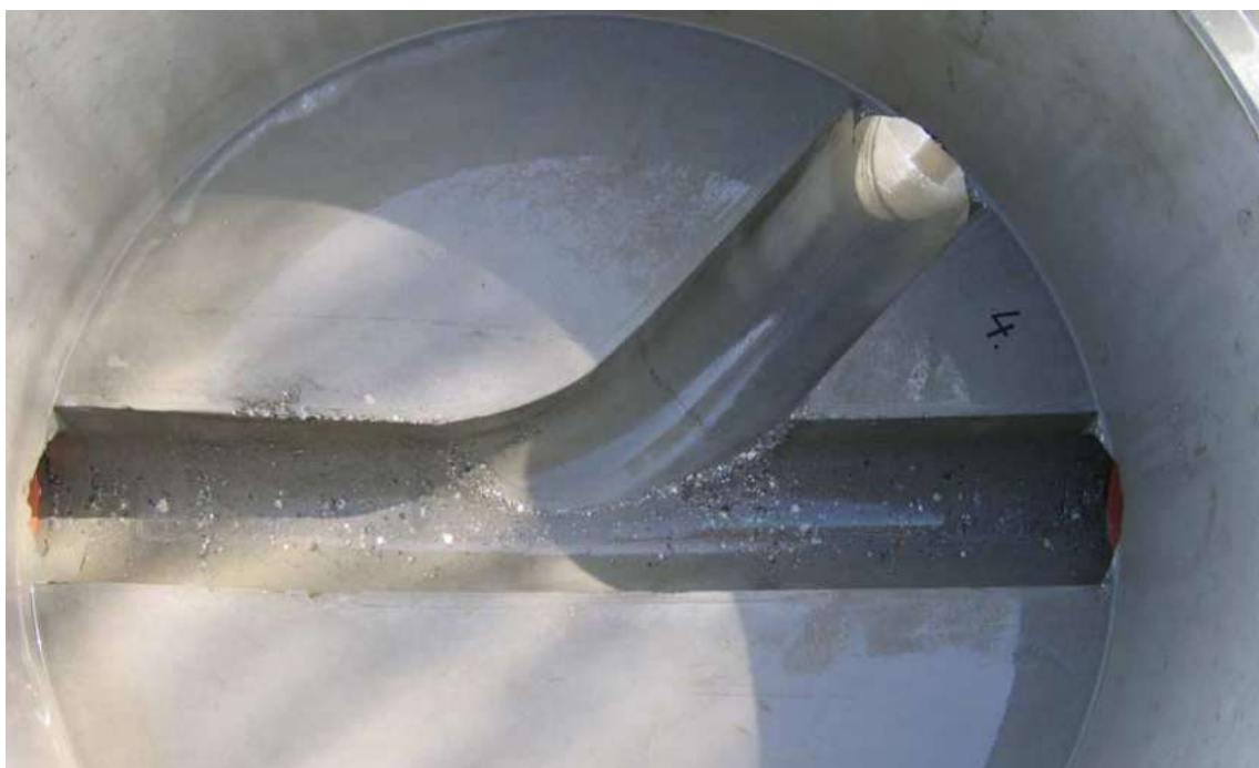
Immagine 31: pozzetto in cls SCC
