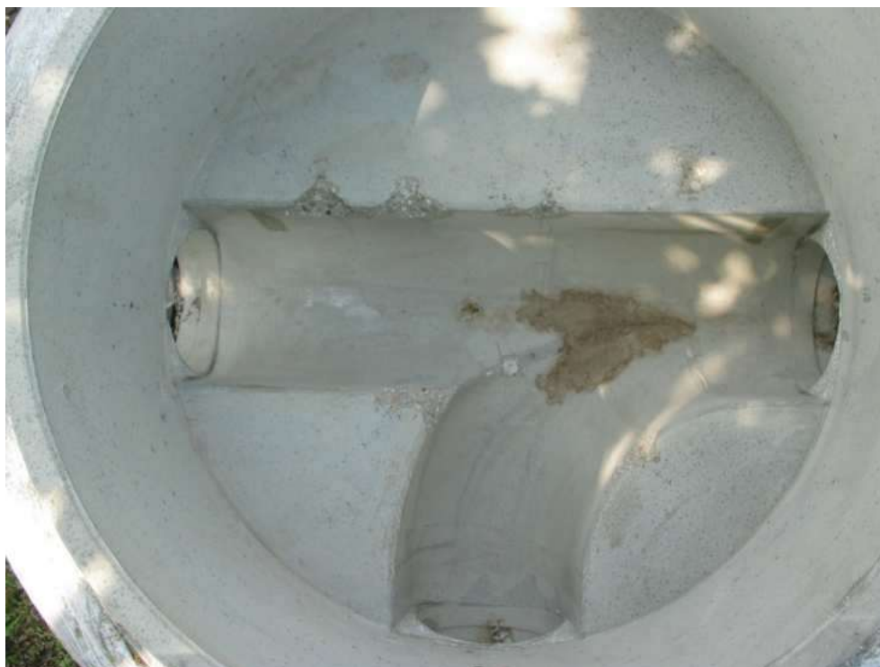
Immagine 18: pozzetto in calcestruzzo
